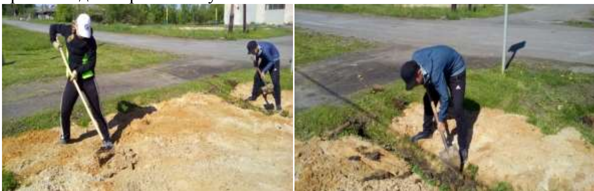
Выровняли площадку под реконструкцию с помощью песка.
